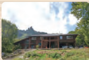
屋根岩と中央棟
